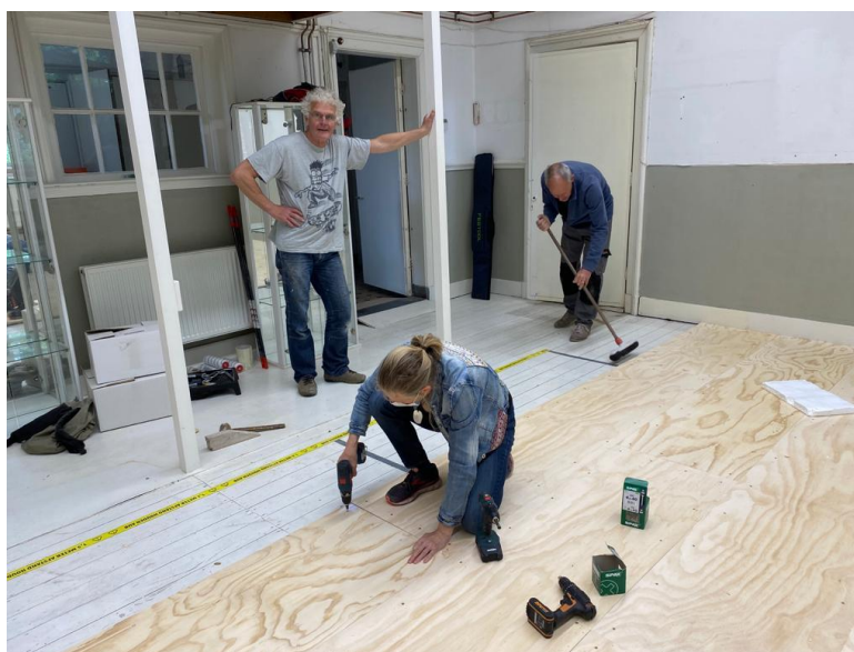
Fred, Anja en Cor in actie met het leggen van de vloer
