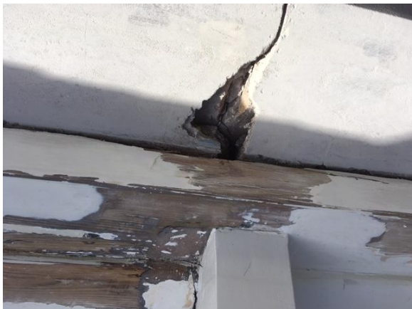
Reparatie rondom de ramen
