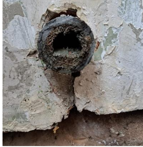
Afvoer in Atelier 2 die voor driekwart dicht zit.
