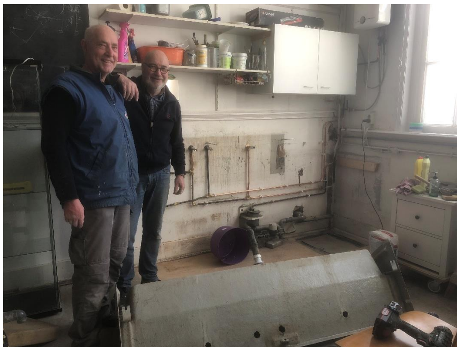
Nieuw leidingwerk in Atelier 2 voor twee nieuwe kranen boven de bezinkbak
